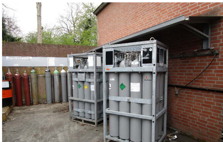
Foto: opstelplaats gasflessen
